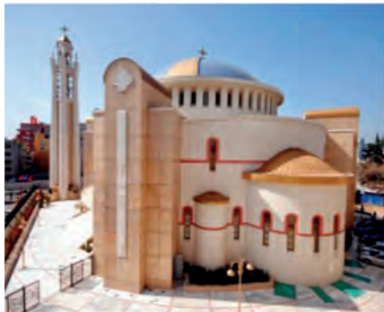
Ναός της Αναστάσεως, Τίρανα
